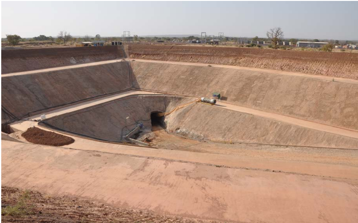
Perkoa Zinc Mine Portal
